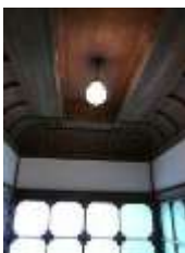
浴室の折上天井
