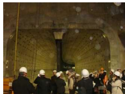
地下鉄工事現場
