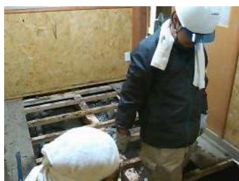
床下ヘドロの除去
