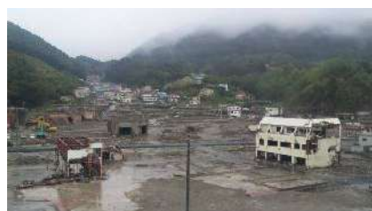
瓦礫撤去の進んだ女川町
