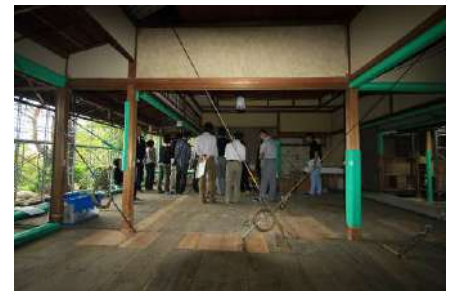
【茶室の耐震補強工事を見学】
