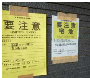
判定ステッカーの貼り付け (左側は応急危険度判定)
