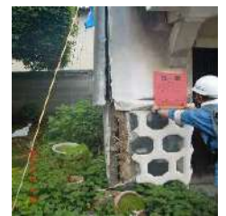
判定ステッカーの貼り付け
